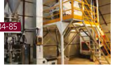
Akkuş Şeker Fasulyesi Paketleme Tesisleri Yapımı Projesi
