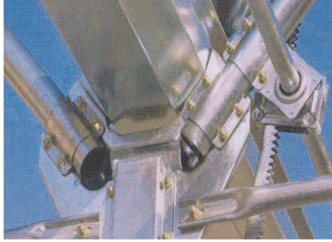
Yağmur olukları ve bağlantıları
